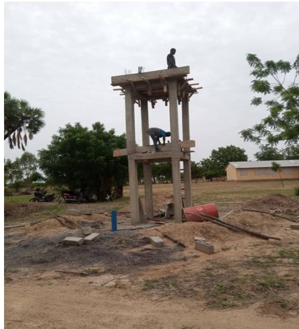
Bau der Tragekonstruktion für den Wassertank
