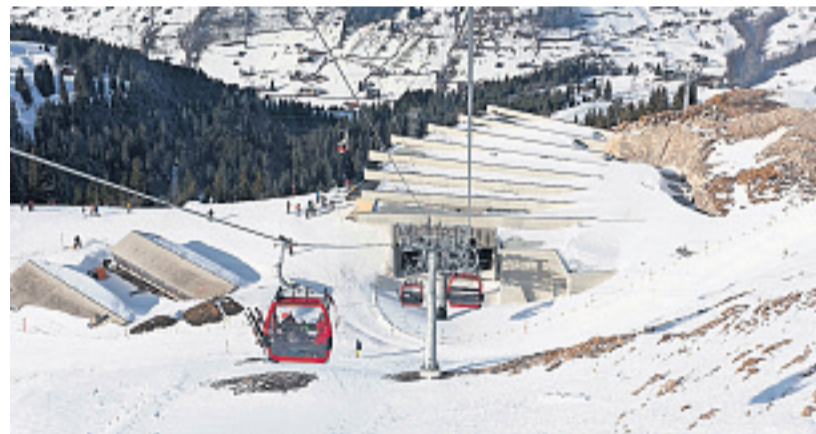
Die neue Garaventa-Gondelbahn mit der von Herzog & de Meuron entworfenen Gondelbahnstation.
